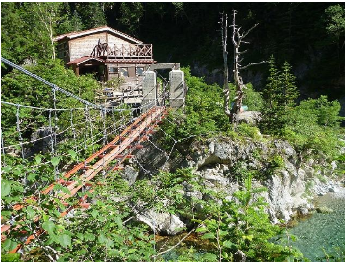
薬師沢小屋からの良く揺れる黒部源流大吊り橋
